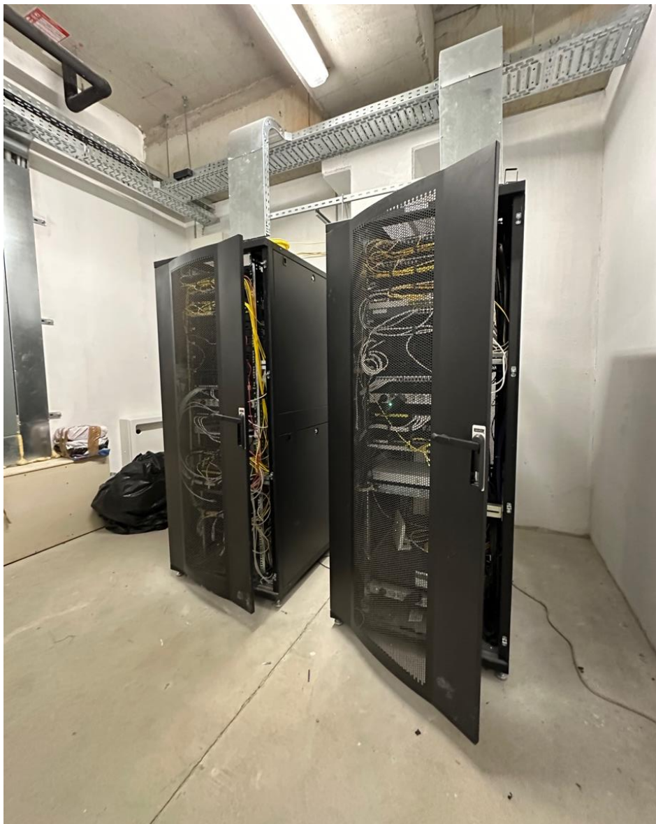
Slika 7 - Glavni UPLINK - dolaz od Hrvatskog Telekom
