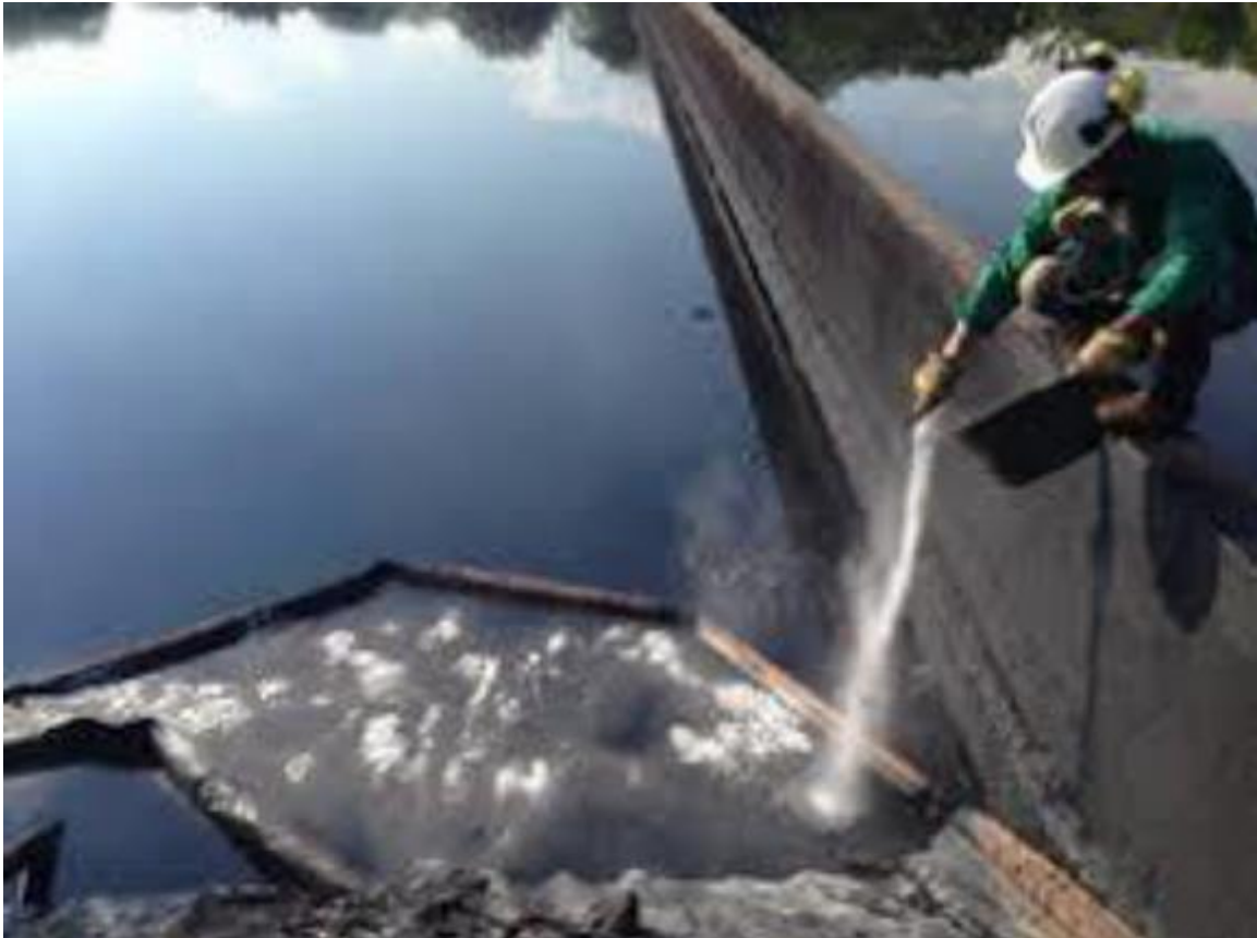
Slika 15. Prikaz primjene sredstava za skrutnjavanje mase
