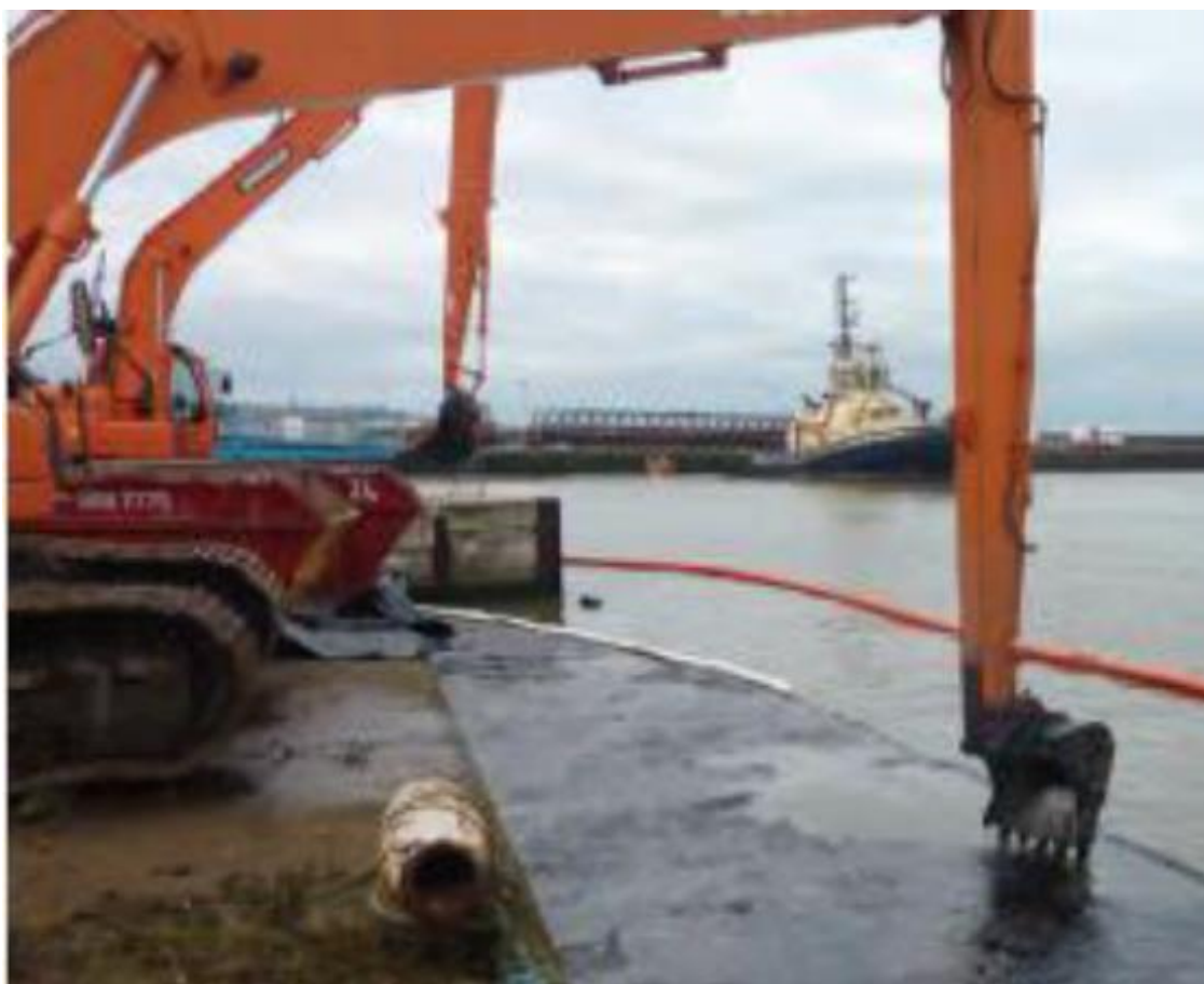
Slika 9. Prikaz uklanjanja ulja korištenjem bagera
