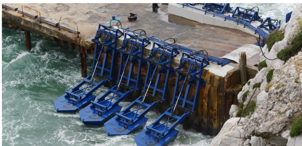
Slika 20: EcoWave Power fiksirani točkasti apsorber valova
