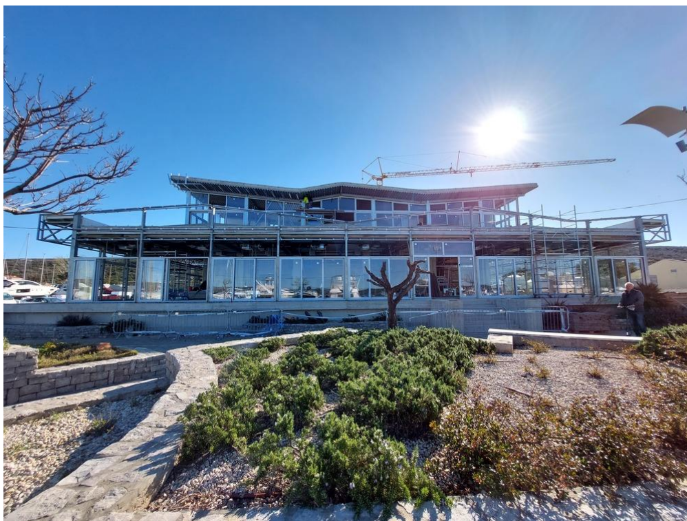
Slika 24. Novi restoran u Marini Punat izgradnji (28.03.2023.)
