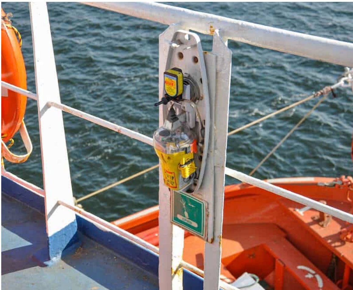
Slika 10. Prikaz ugrađenog uređaja EPIRB na brodu
