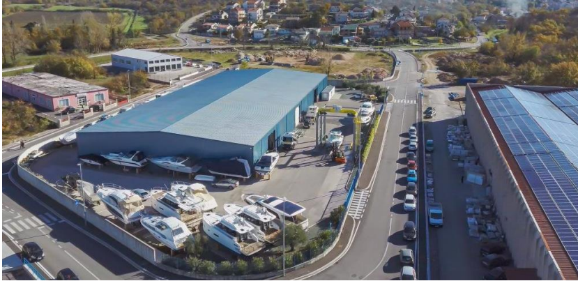
Slika 2. Suhi vez (hangar) Mitan marine u Novom vinodolskom
