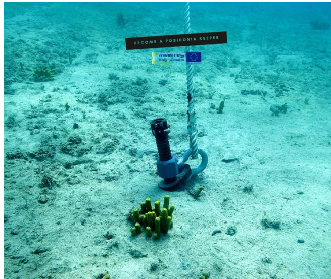
Slika 22. Sidreni vijak ubušen u morsko dno u NP Kornati
