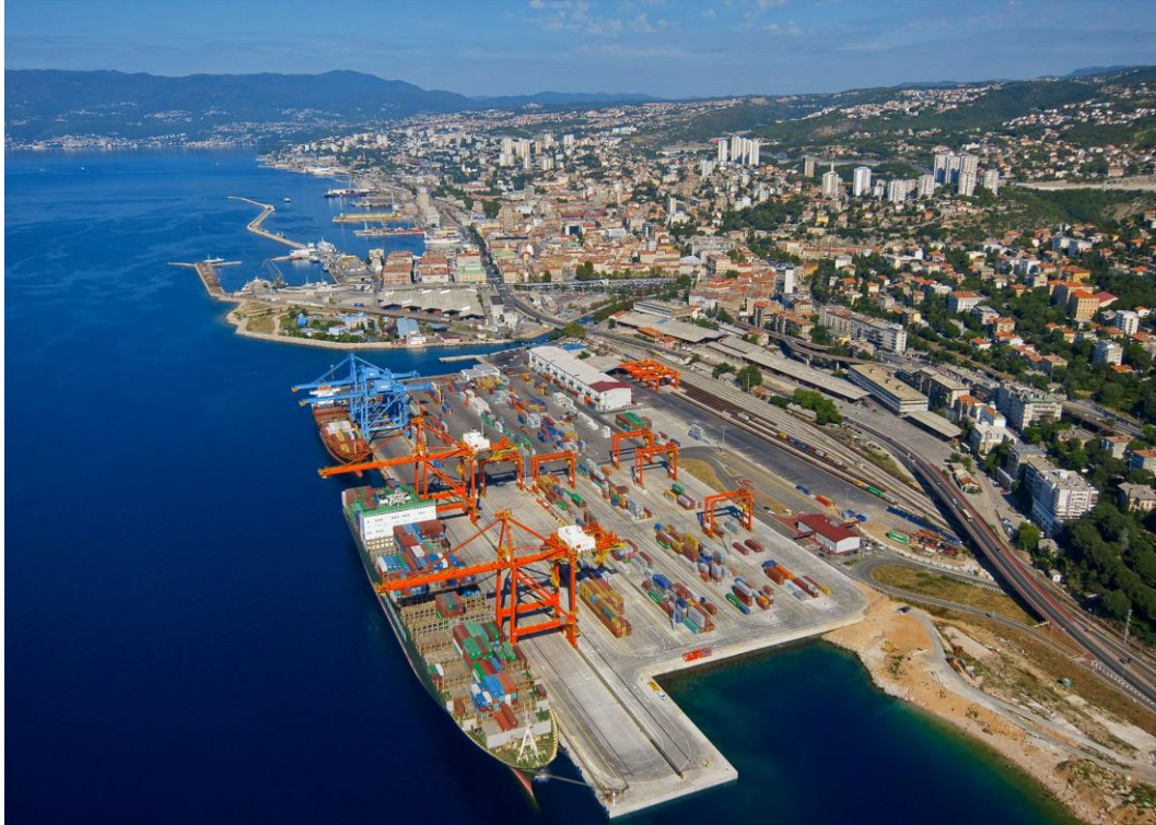
Slika 3. Kontejnerski terminal Brajdica
