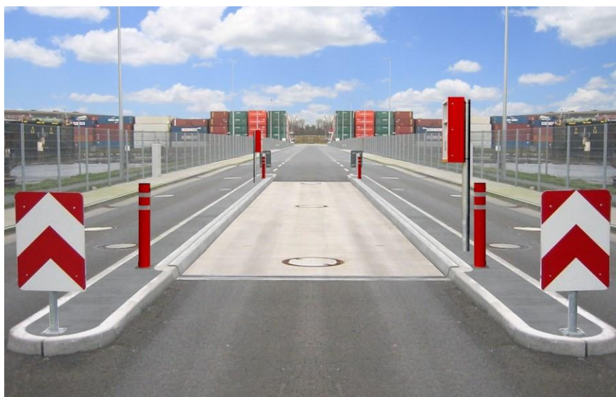
Slika 2 Traka za vaganje teretnih vozila
