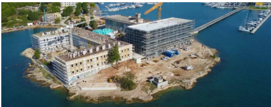
Slika 36 .Hotelski kompleks u izgradnji
