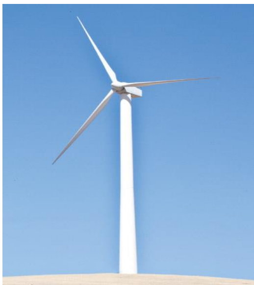
Slika 11. Vjetroturbina s horizontalnom osi vrtnje rotora (HAWT)
