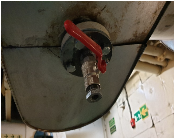
Slika 38. Kuglični ventil za priključak sonde
