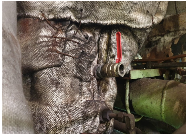
Slika 39. Kuglični ventil za priključak sonde 2
